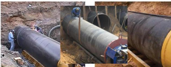
Бестраншейная прокладка инженерных сетей, путем продавливания стальных футляров
